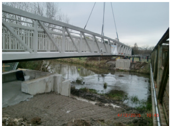
Montage Aluminiumüberbau
