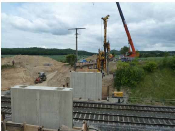
9.6.2015 Ausschalarbeiten Pfeiler A 2 und Bohrpfahlarbeiten WL B
