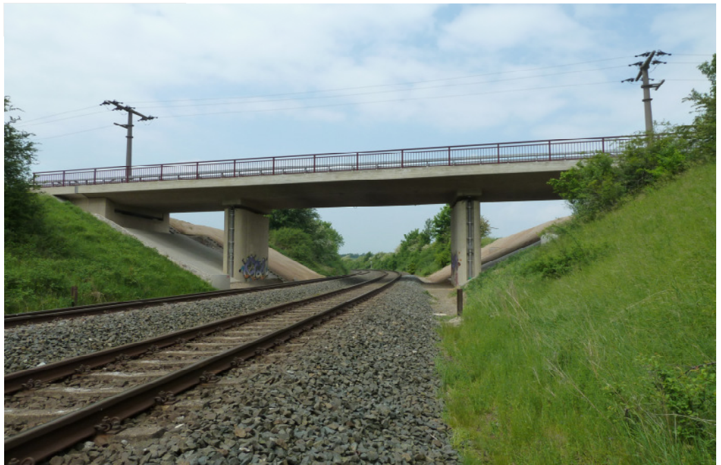
ENB ü. d. DB K 1 zwischen Goslar - Jerstedt und Hahndorf Bauwerk 12304 Ansicht Süd
